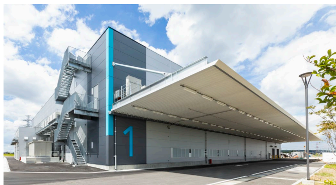
第1組立棟（2023年稼働）
